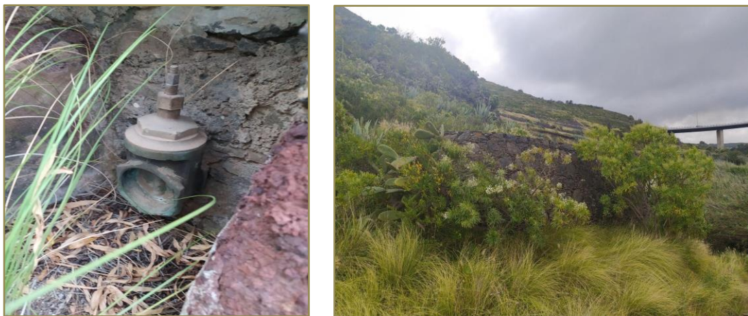
Foto detalle estanque. A la izquierda, base del estanque con llave y enganche a riego en base del estanque. A la derecha foto de las paredes de piedra del estanque.
